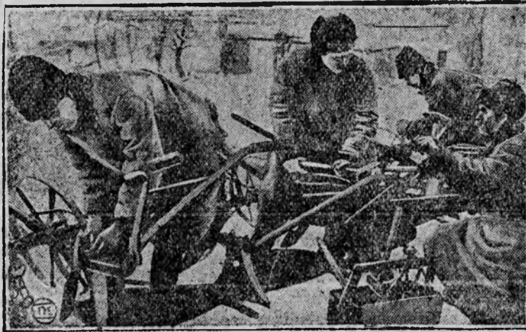
Кузицы ударники за ремонт сельхоз-инвентаря в колхозе „Борец“, село Людовка, УССР.
